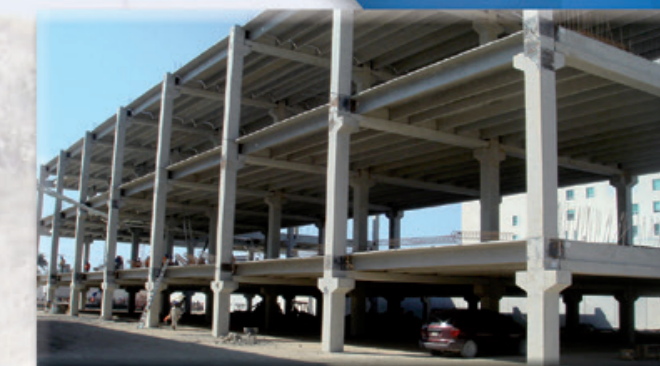
Columnas, Traveses y Losas TT
